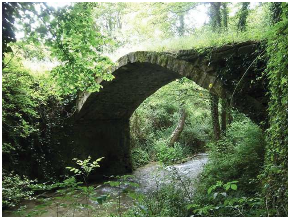
Fig. 12 - Il ponte medievale del "Cicaleto"
