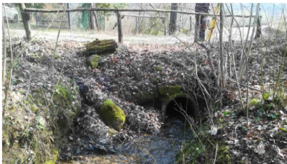
Foto del collettore circolare che drena le acque provenienti da monte attraverso un rilevato carrabile
