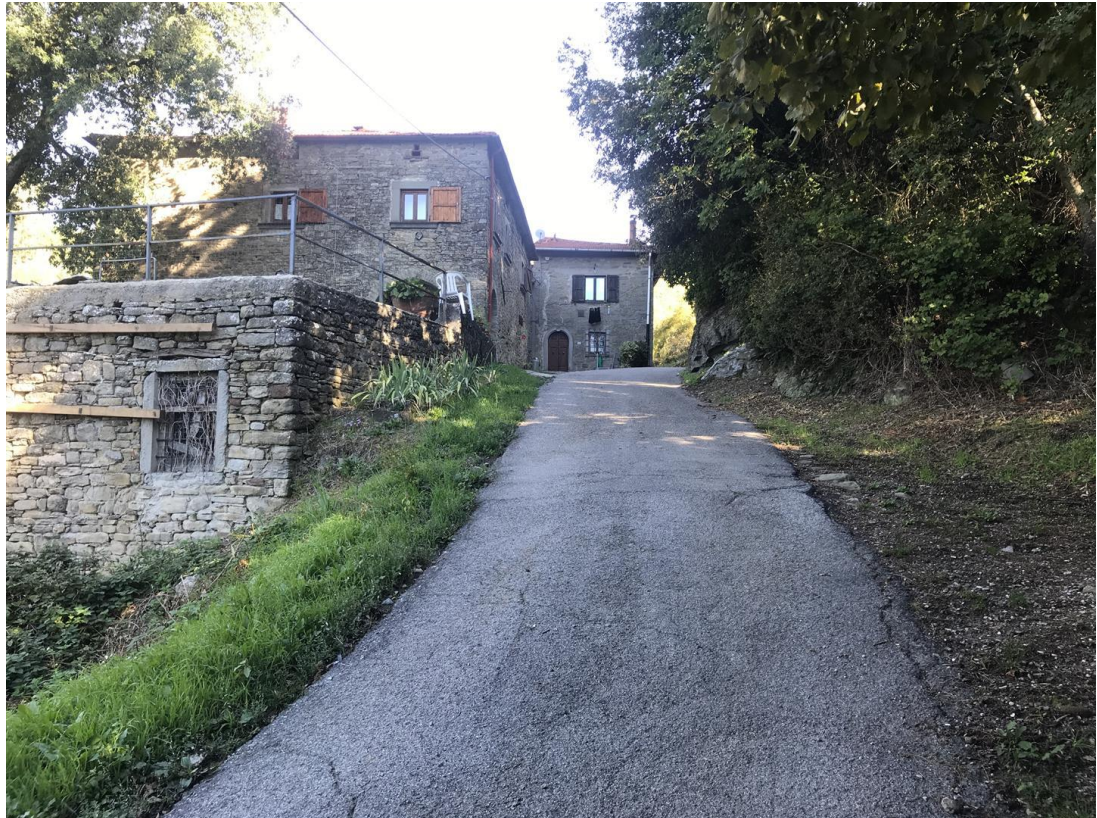
Foto n. 5 - Vista del tratto stradale in direzione il Prato
